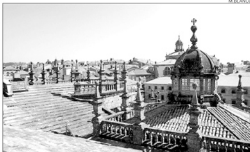
Las cubiertas de piedra de la Catedral serán visitables
